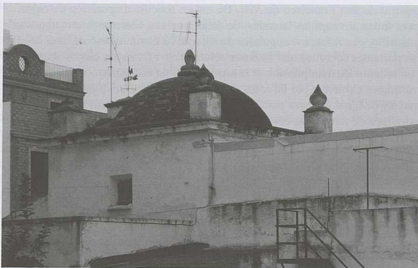
Lám. 4. ¿Capilla del Venerable Orden Tercero?
