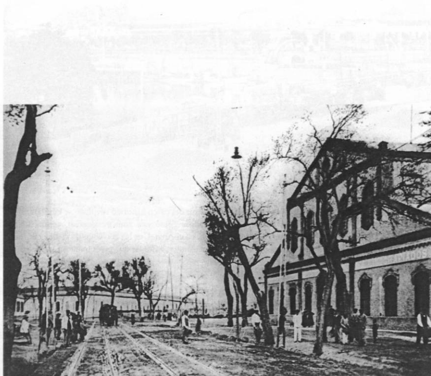
Foto 5. En los espacios periurbanos del nordeste de la ciudad, muy próximos a las antiguas murallas de la ciudad, en las actuales avenidas de Miraflores, María Auxiliadora, Ronda de Capuchinos y la antigua carretera de Carmona, se ubicaron una serie de fábricas a finales del siglo XIX y principios del XX, normalmente de grandes dimensiones, entre las que podemos destacar las de hojalata y litografía de Gallardo y Núñez (a la derecha en la foto), la de aderezo de aceitunas de Diego González y Hermanos (al fondo de la foto), la de corcho de Armstrong Cork y Cía. y la de vidrios de la Trinidad, al igual que otras textiles, madereras o de quincallería de tamaño medio.
