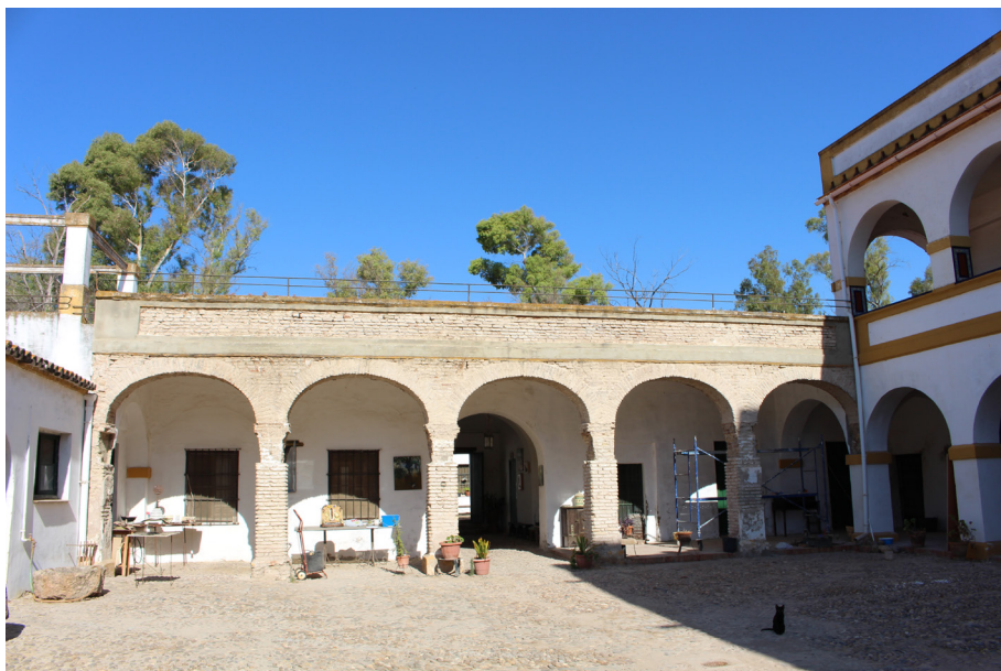
FIG. 10. Patio de sementales. Galerías, terraza y pérgola (Foto autora).
