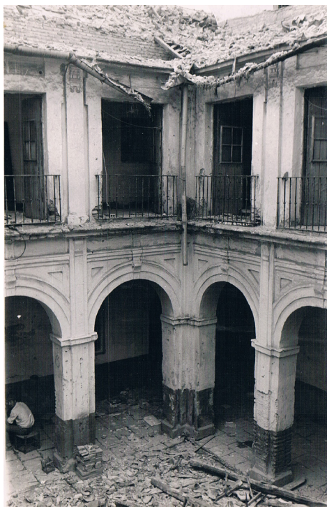
FIG. 6. Anónimo. Vista del patio desde un ángulo con acopio de material. Calle Jesús del gran Poder nº 66. 16 de abril de 1968. Colección AMP.
