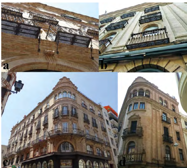
FIG. 11. Comparativa edificio Enríquez Barrios (Córdoba) (dcha.) y edificio Javier Sánchez Dalp (Sevilla) (izda.). (a) Uso del azulejo en los balcones del edificio Enríquez Barrios. Córdoba. Fotografía de Elías Mérida Serrano. (b) Uso del azulejo en los balcones del edificio Javier Sánchez Dalp. Sevilla. Fotografía de Elías Mérida Serrano. (c) Balconadas en forja y esquina del edificio Enríquez Barrios. Córdoba. Fotografía de Elías Mérida Serrano. (d) Balconadas en forja y esquina en curva del edificio Javier Sánchez Dalp. Calle Tetuán esquina a Rioja. Sevilla. Fotografía de Elías Mérida Serrano.
