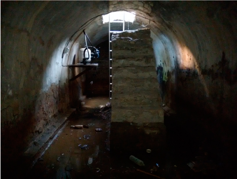
FIG. 2. Vista de una de las escaleras del aljibe oriental.
