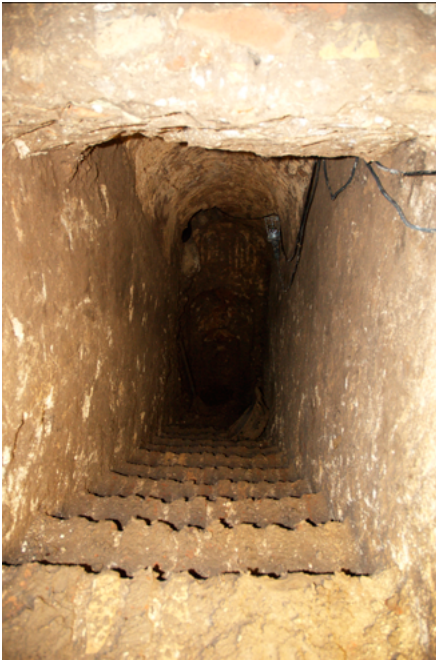
FIG. 7. Escalera de bajada a la galería.
