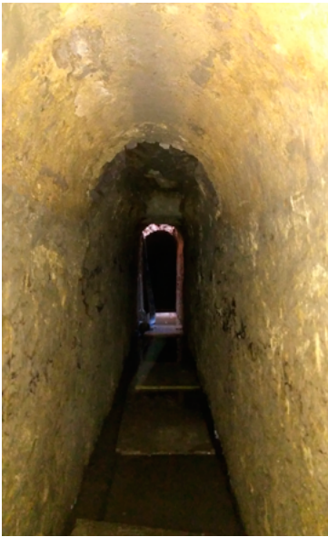
FIG. 10. Vista de la galería.
