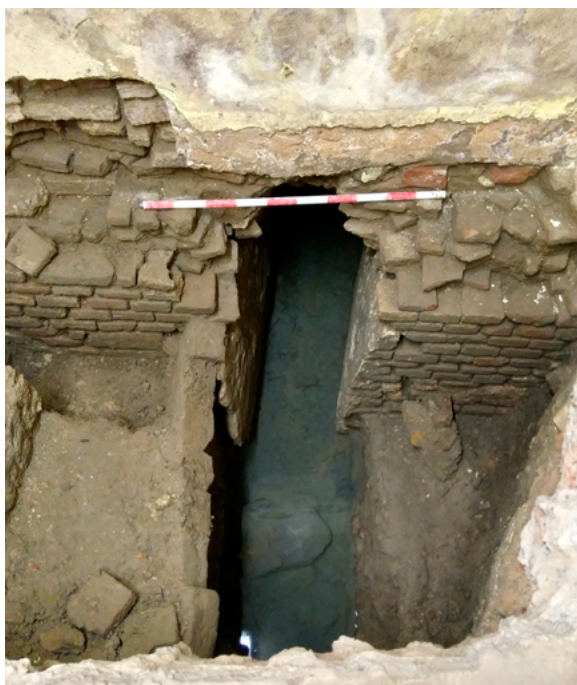
FIG. 12. Cata en la cripta del Sagra-rio. Contacto entre la galería y el muro de fachada.
