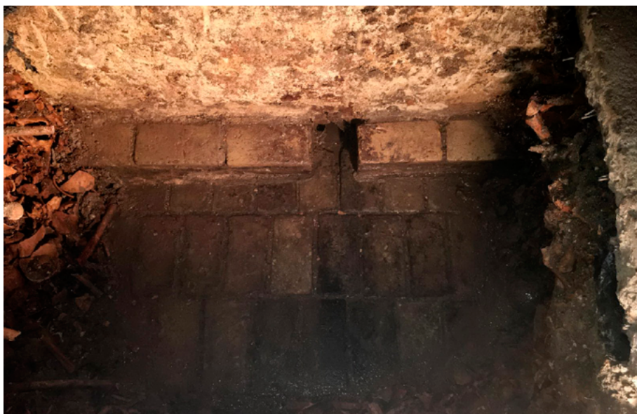
FIG. 9. Detalle del desagüe por el interior del aljibe occidental.
