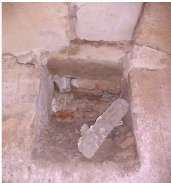
FIG. 1. Lucernario original del aljibe oriental.
