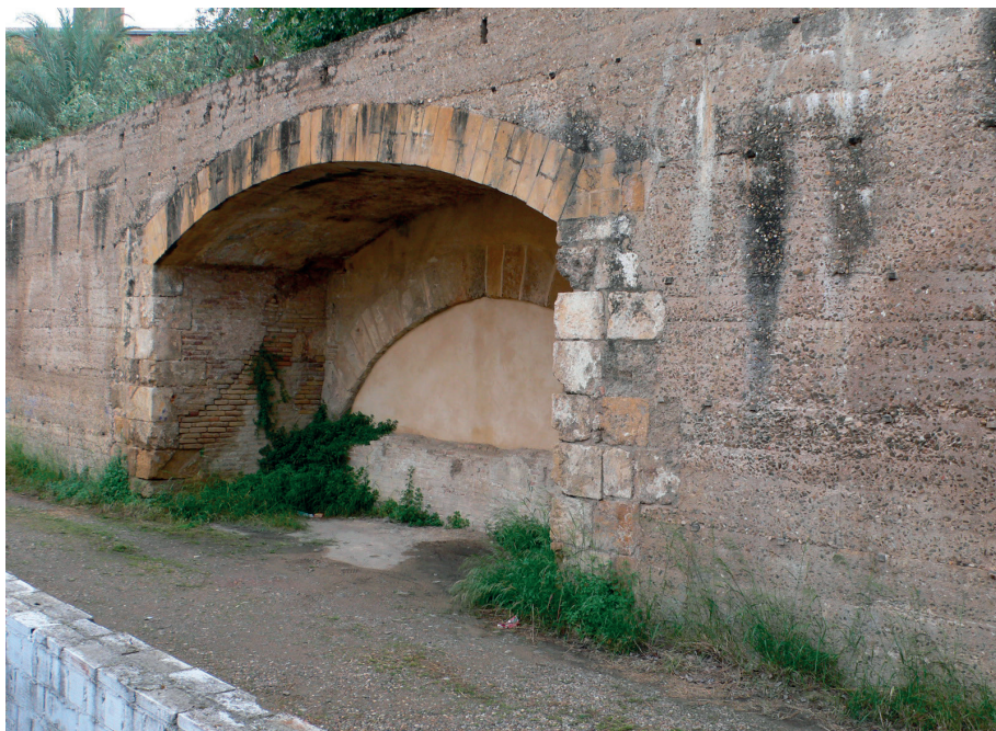
FIG. 4. Arco norte, conservado en el muro oeste del recinto de la Casa de la Moneda, en su estado actual tras la restauración. (F. Amores).
