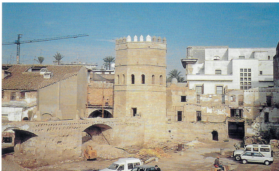
FIG. 3. Imagen del lienzo oeste de la Casa de la Moneda en proceso de restauración (1989) donde se observan los dos vanos gemelos con arcos rebajados (J. García Tapial y J. M. Cabeza Méndez).
