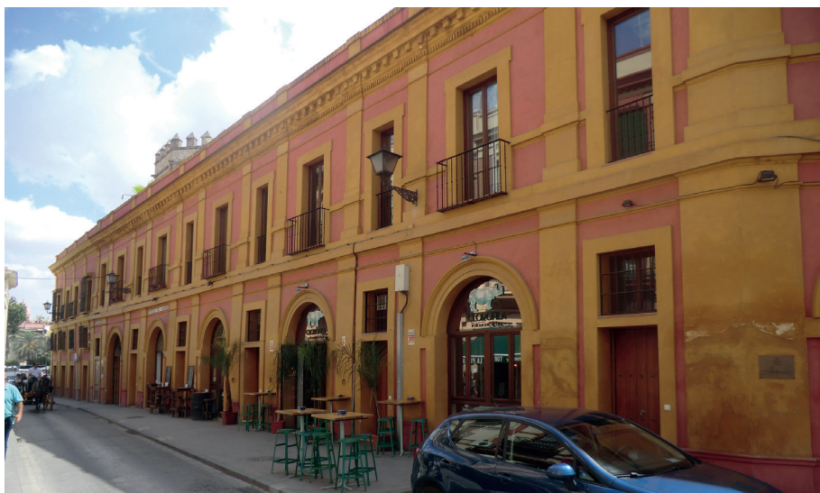
FIG. 8. Fachada de las viviendas de la C/Santander. Fotografía del autor.
