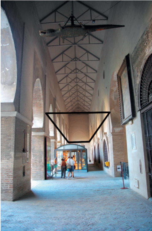
FIG. 9. Fotografía de la galería del Lagarto en 2004 (foto del autor).
