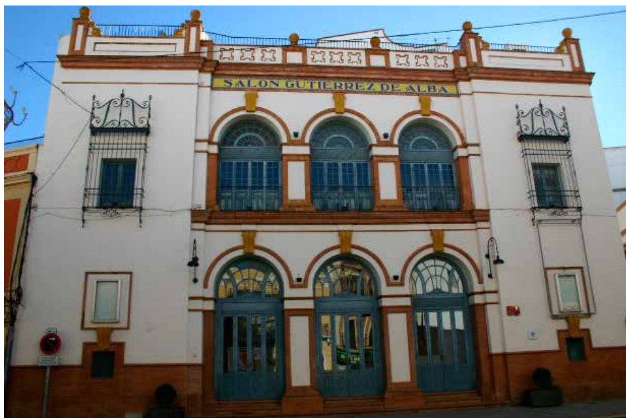
FIG. 8. Teatro Gutiérrez de Alba. Fachada principal, estado actual. (Foto autora).
