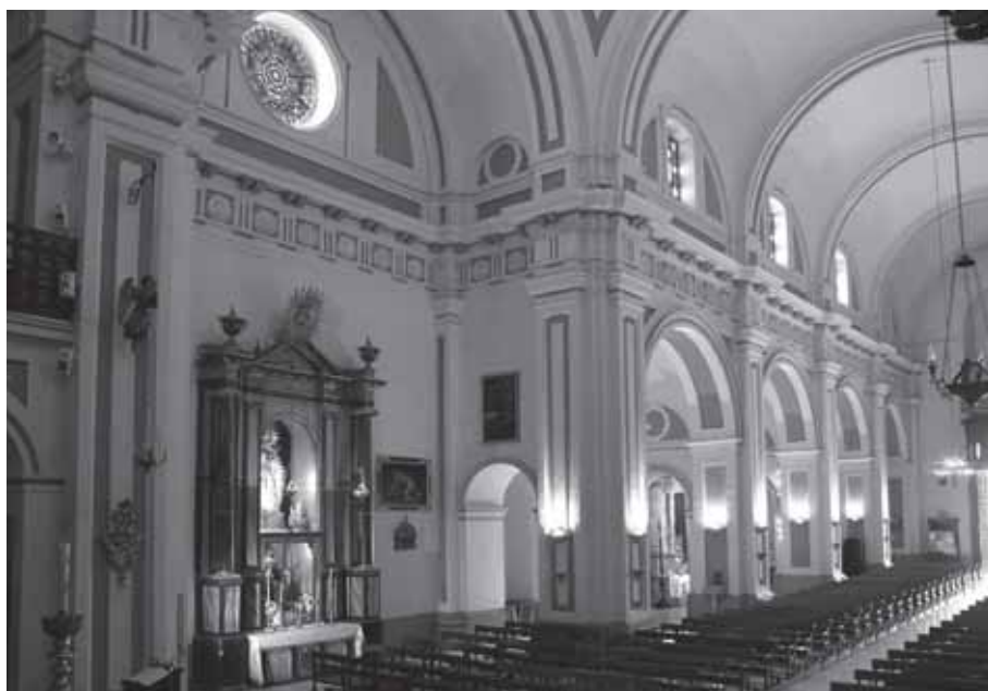
FIG. 6. Interior. Articulación muraria.
