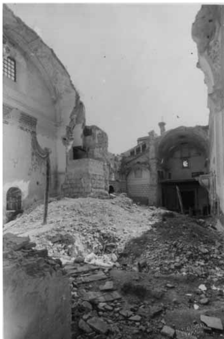
Fig. 4. Osuna. Interior del Convento de San Francisco (1946). Vista desde los pies. Fototeca de Laboratorio de Arte
