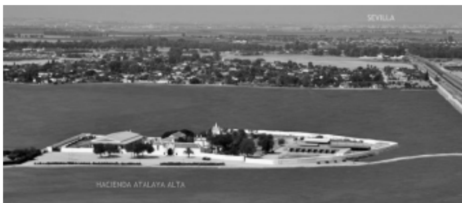
FIG. 2. Vista actual de la Hacienda Atalaya Alta. Fuente: www.haciendaatalaya.com/historia.htm
