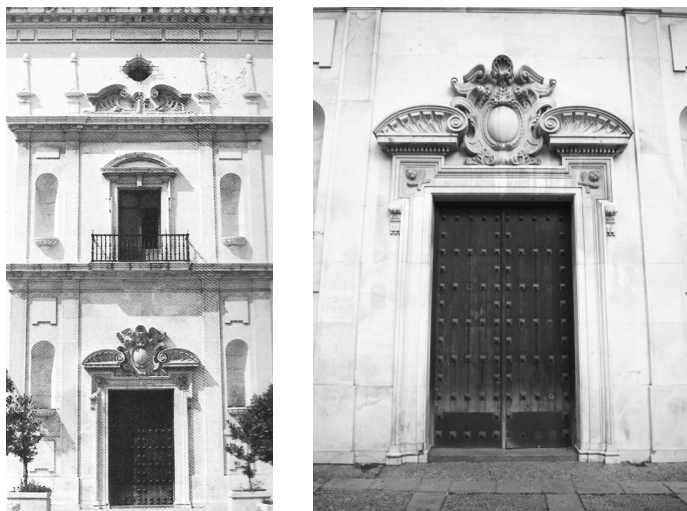
Iglesia del Colegio Hno. Pedro Sánchez (1616-1619). Fachada principal y detalle de la puerta.
