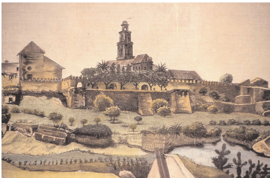
LÁM. 1. Vista del palacio a mediados del siglo XIX.
