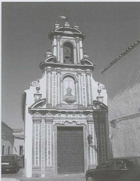
Fig.19. Hospital de la Caridad. Carmona. Fachada espadaña.
