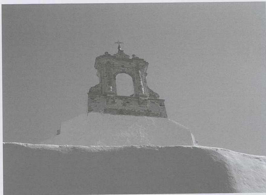
Fig. 7. Ermita de San Mateo. Carmona. Espadaña.
