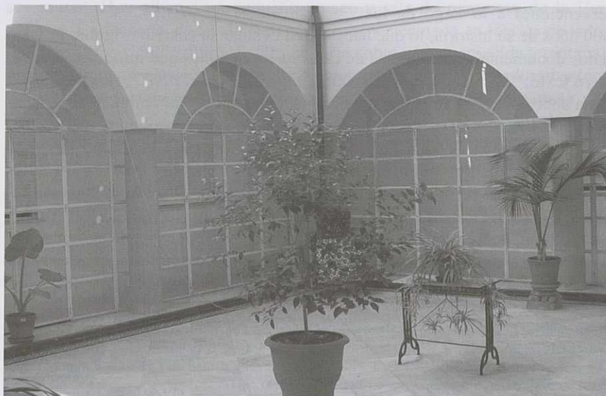
Fig.21. Hospital de la Caridad. Carmona. Patio de servicios del asilo.
