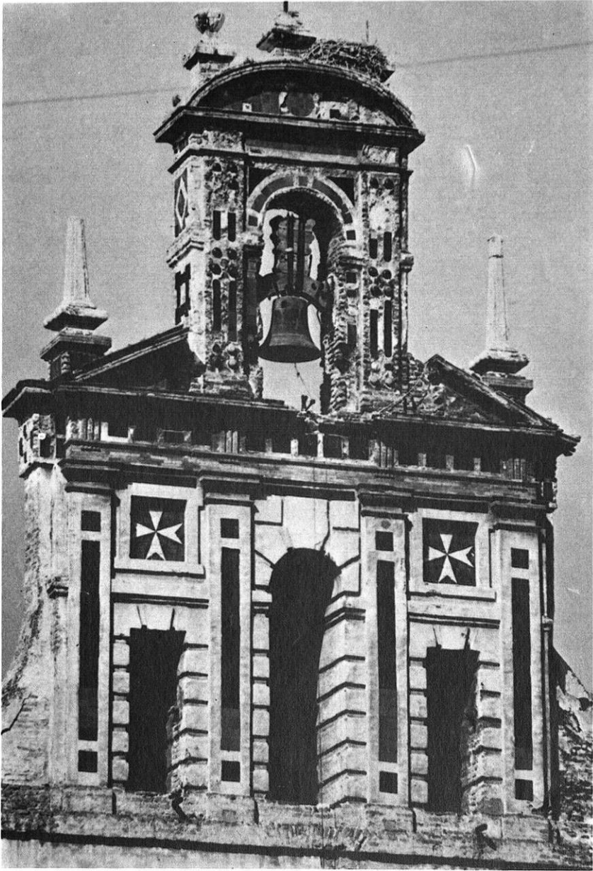
Fig. 2. Sevilla. Convento de Santa Isabel. Espadaña.
