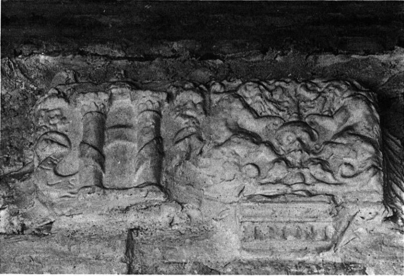
Lám. 2. Fig. 2. Detalle de los frisos de yeserías de la galería alta del Patio de las Doncellas.
