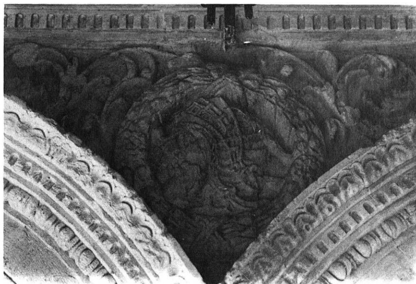
Lám. 3. Fig. 2. Detalle de la decoración de las arquivoltas. Galeria de poniente. Patio de las Doncellas.
