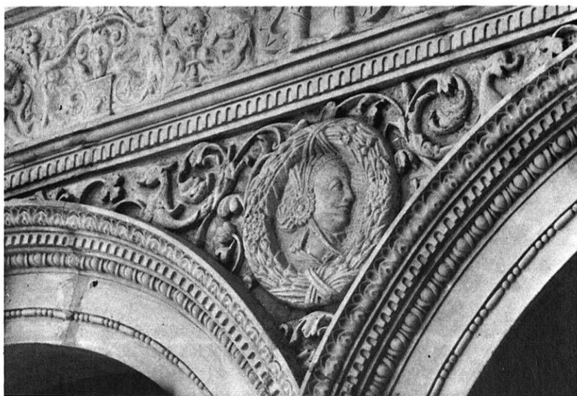
Lám. 4. Fig. 1. Tondo de la emperatriz Isabel. Detalle de la restauración de uno de los frentes exteriores del Patio de las Doncellas.
