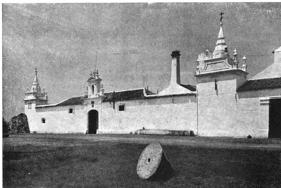
Fig. 20. —Fachada principal de la Hacienda La Plata.—Carmona.
