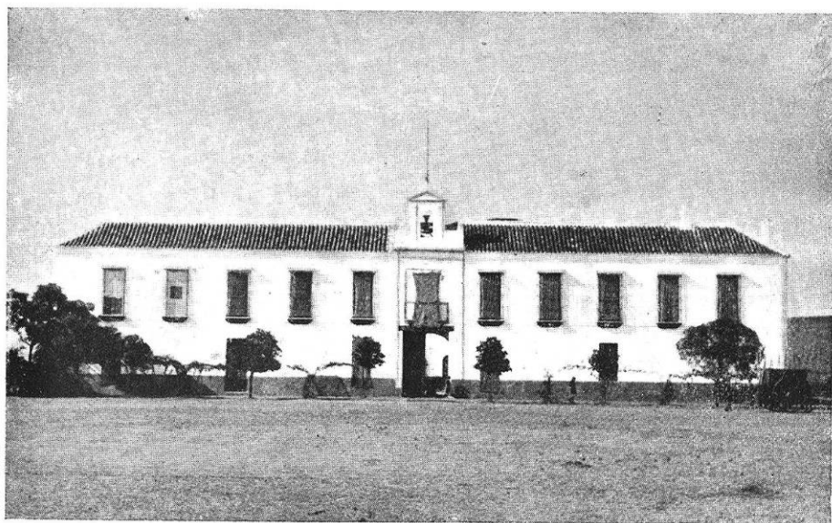
Fig. 36. —Fachada del cortijo de Guadalbardilla. - - Carmona.
