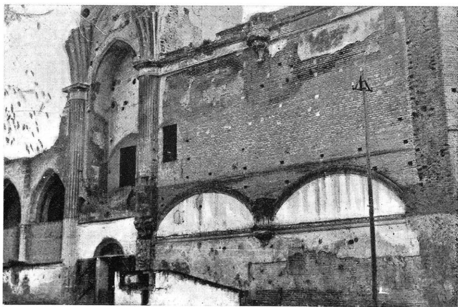
Fig. 6.—Muro del coro.
